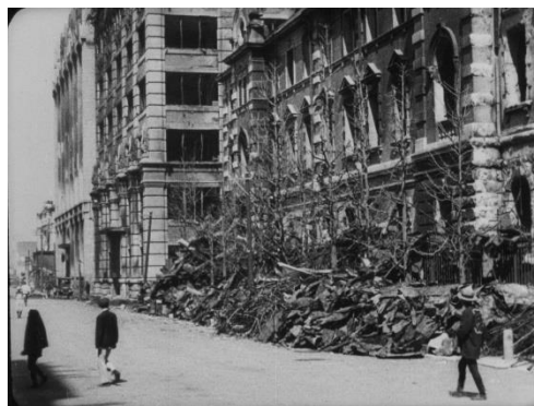
場所：中央／シーン：焼失、倒潰・損壊
