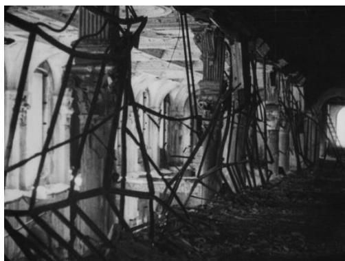
場所：中央／シーン：焼失、倒潰・損壊
