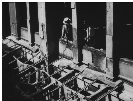
場所：中央／シーン：焼失、倒潰・損壊
