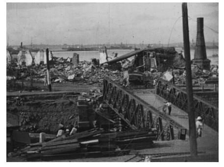
場所：横浜／シーン：焼失、倒潰・損壊
