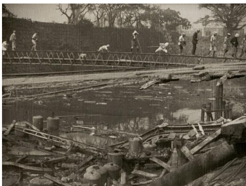
『東京大震災』 場所：千代田／シーン：倒潰・損壊,復旧 日本橋川に架かる神田橋が地震により墜落し、仮設の橋を人々が列をなして渡っていく。
