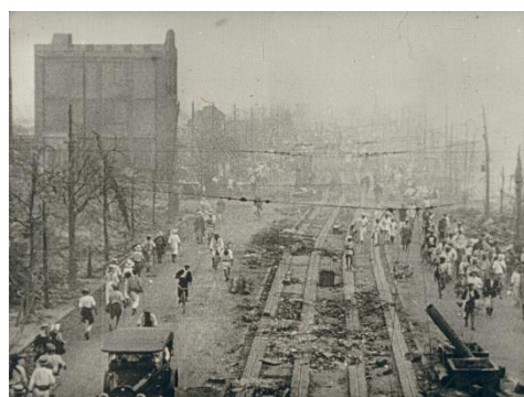
『東京大震災』 場所：千代田／シーン：焼失,倒潰・損壊,避難
